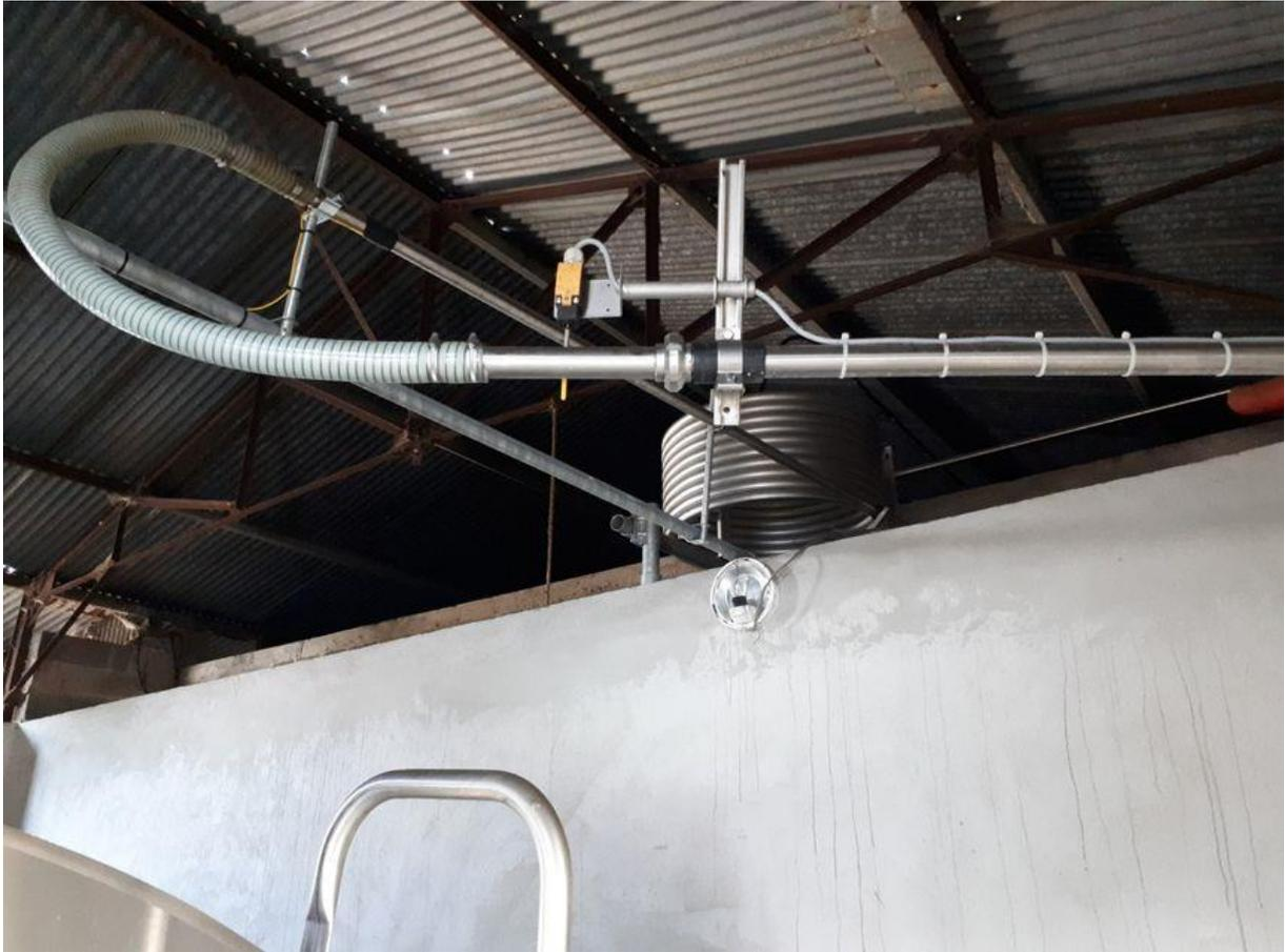
Chez Samuel Barrier, en Mayenne, le lait, une fois la vache traitée, passe dans un pré-refroidisseur tourbillonnant puis dans un tuyau jusqu'à la cuve de refroidissement. © Radio France - Théo Boscher
