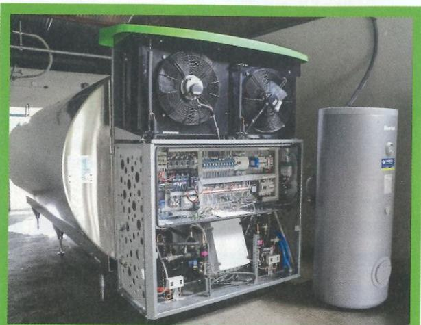
Le groupe frigorifique comporte trois parties : en haut les ventilateurs à puissance variable, au milieu le coffret électrique de régulation, en bas les compresseurs détenteurs assurant le refroidissement du lait. ©A. Conté
