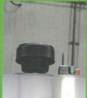
Le capteur de niveau permet d'adapter la puissance électrique à la quantité de lait arrivant dans le tank. ©A. Conté
