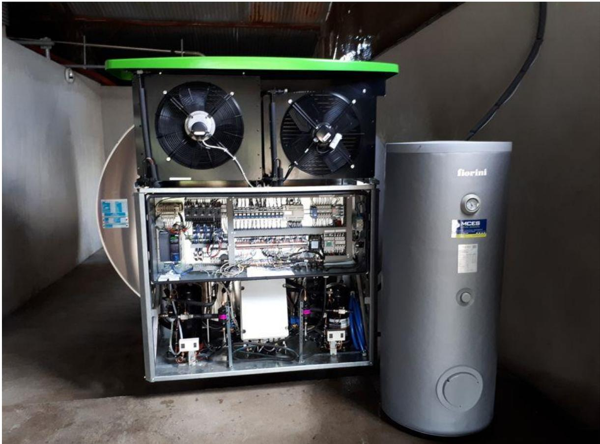
Les ventilateurs se déclenchent en fonction de la quantité de lait à refroidir pour ne pas consommer trop d'énergie. Exploitation de Samuel Barrier, en Mayenne. © Radio France - Théo Boscher
