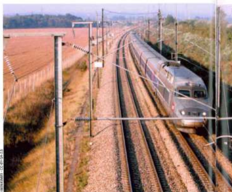
La réalisation de la LGV Bretagne-Pays de la Loire a permis de rapprocher Laval de Paris à 1h10, ou plutôt « 70 minutes ».
